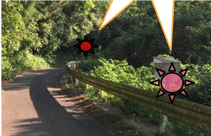
サイクリングイベントを行うコース上に、見通しの悪いカーブごとに**電子対向車検知装置「見張り灯籠」**を設置し、見張り灯籠間をZigBee通信で連携させ、警告灯の点滅周期で対向者との距離を知らせます。
